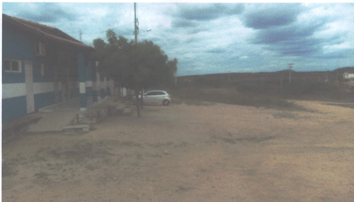
DIST. DE LAGOA DO MATO - RUA DO PSF 6 (INICIO) (E=426293.601 ; N=9485684.047)
