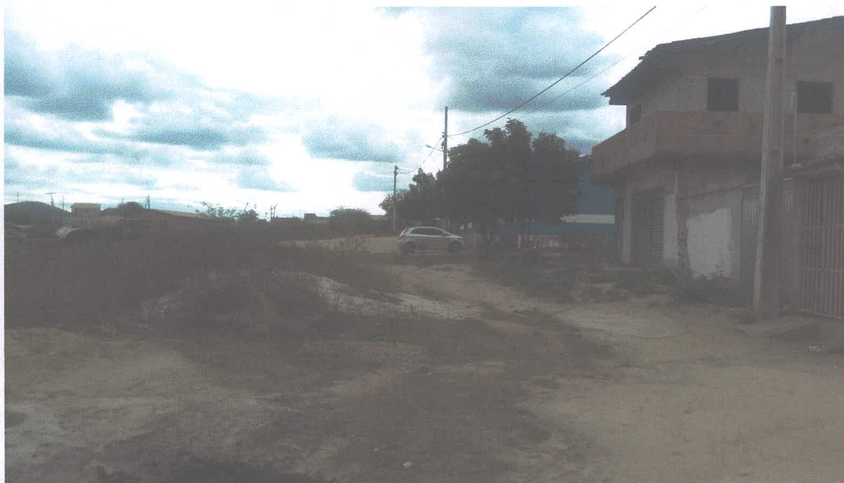
DIST. DE LAGOA DO MATO - RUA DO PSF 6 (FIM) (E=426347.616 ; N=9485632.761)
