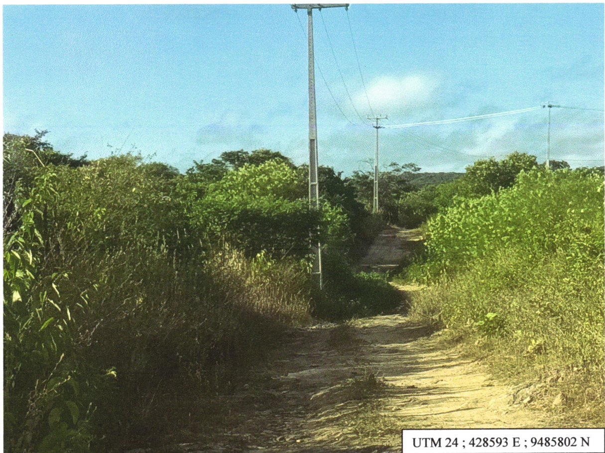
FOTO DO LOCAL DA OBRA – INICIO
