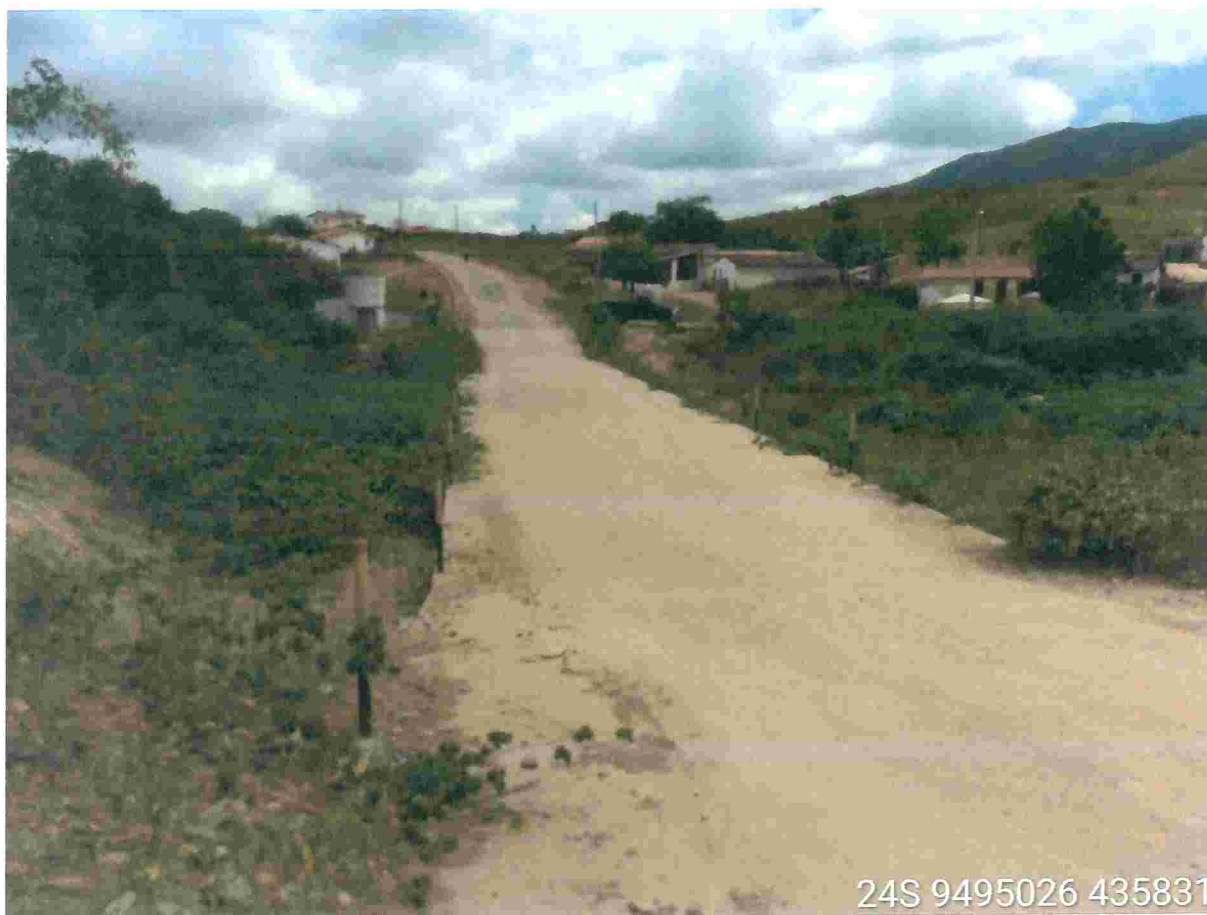
FOTO DO LOCAL DA OBRA
